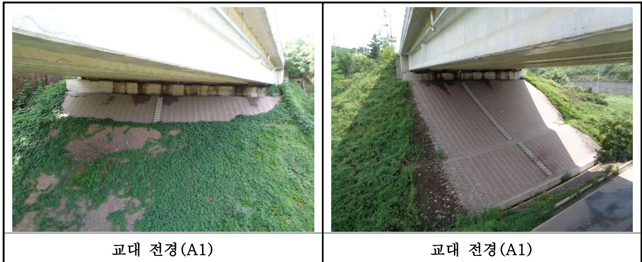
【사진 24.3.8】 교대 전경
