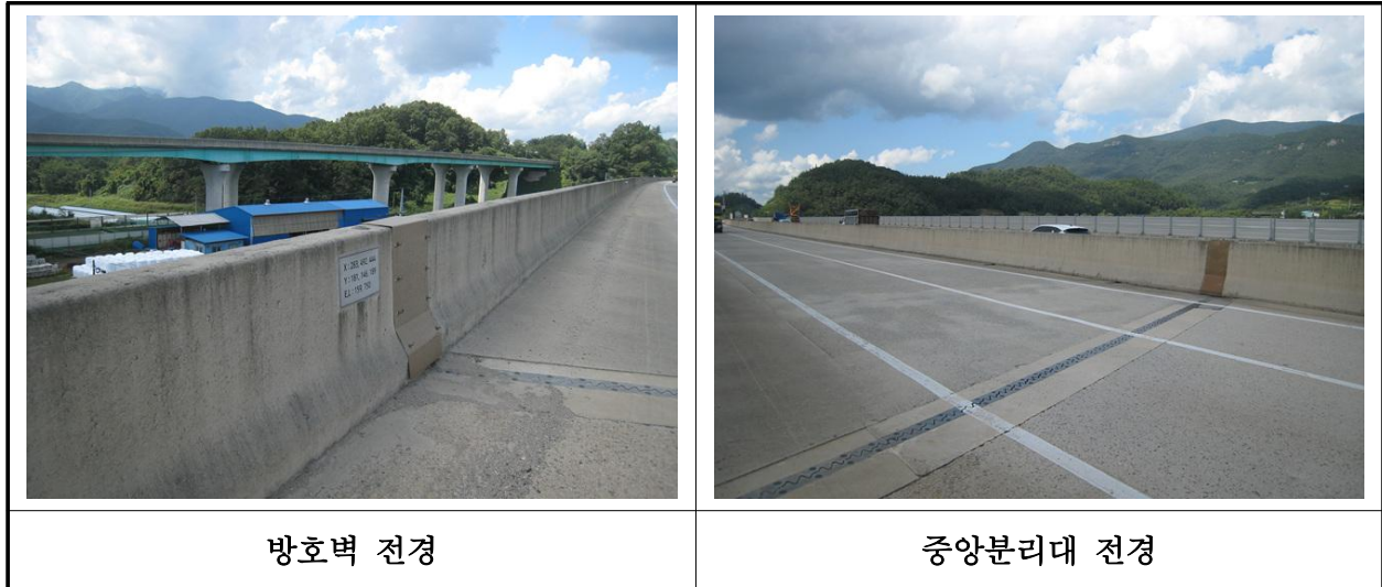
【사진 24.3.23】 방호벽 및 중앙분리대 전경
