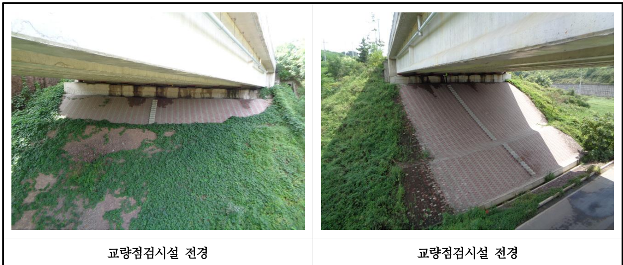
【사진 24.3.25】 교량 점검시설 전경
