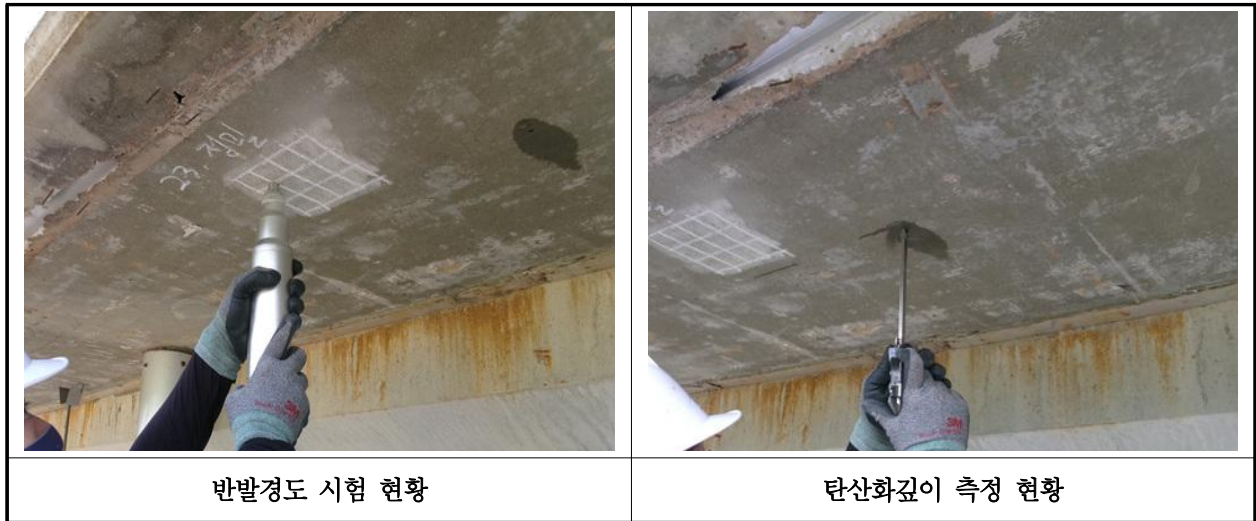
【사진 24.4.1】 콘크리트 내구성조사 현황
