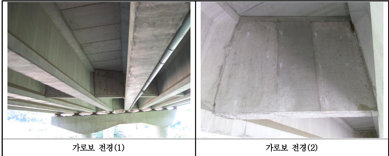
【사진 24.3.6】 가로보 전경
