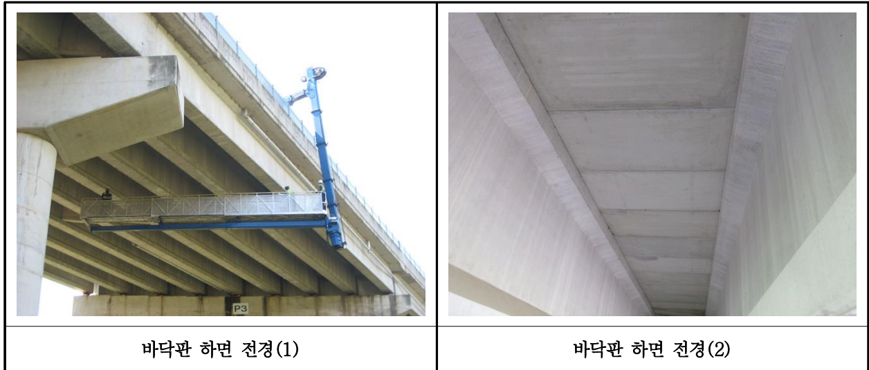
【사진 24.3.2】 바닥판하면 전경
