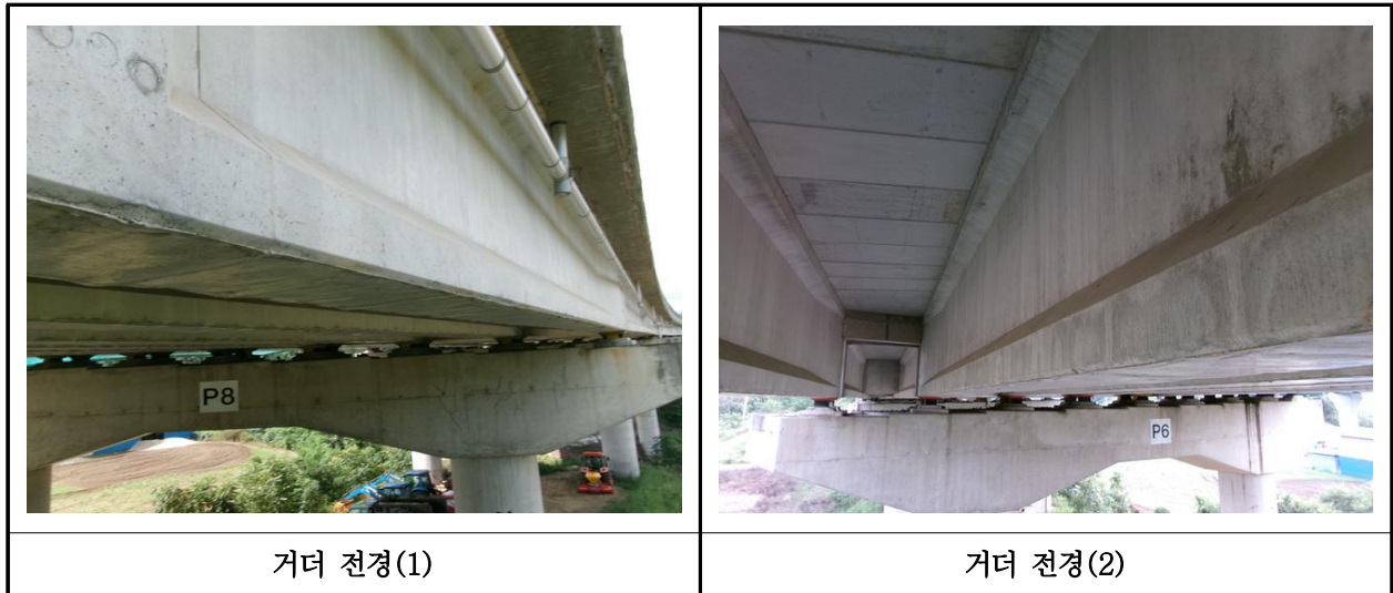
【사진 24.3.4】 거더 전경
