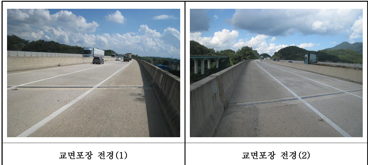
【사진 24.3.19】 교면포장 전경
