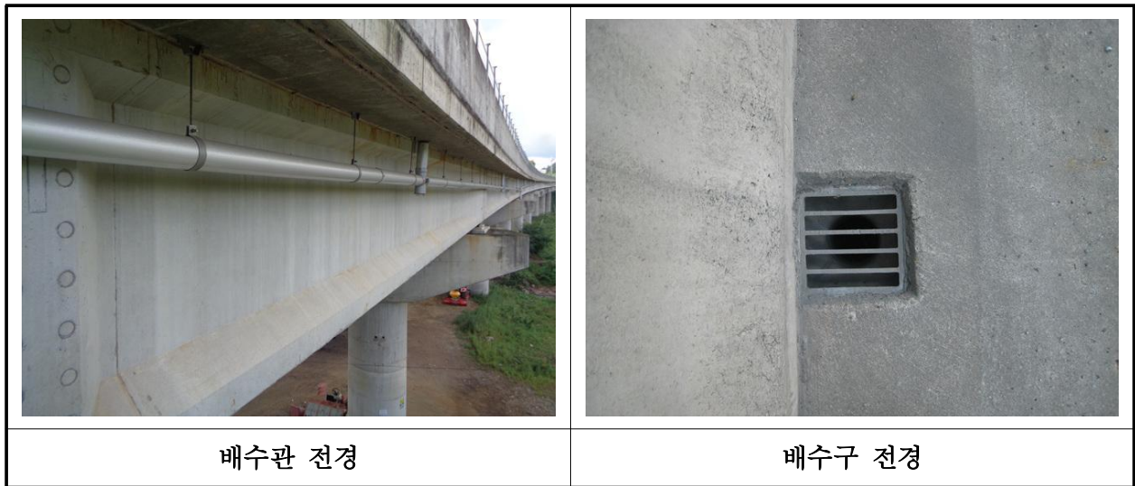
【사진 24.3.21】 배수시설 전경
