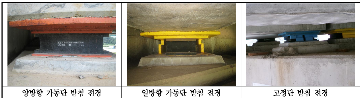
【사진 24.3.12】 교량받침 전경
